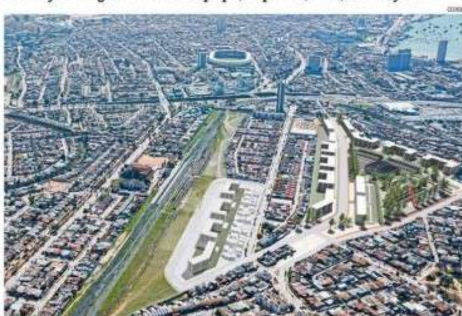
EL PROYECTO "MAESTRANZA" EN COQUIMBO, CONSIDERA LA CONSTRUCCIÓN DE UN PARQUE DE 2,5 HECTÁREAS.
