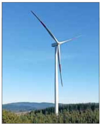
Hay innovaciones para facilitar el ingreso de energía renovable.
