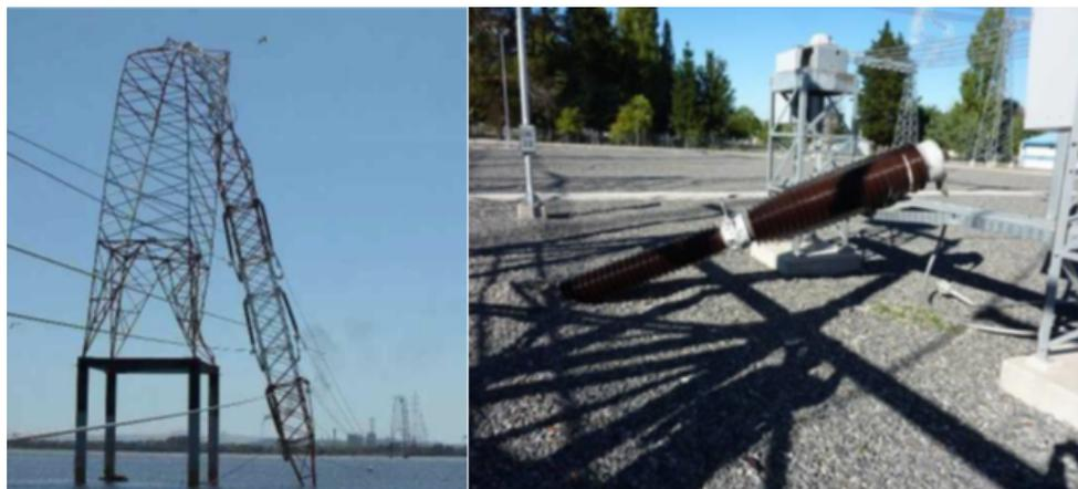
Figura 2: Daño en línea y subestación del SEN por terremoto, 27 Feb 2010.
